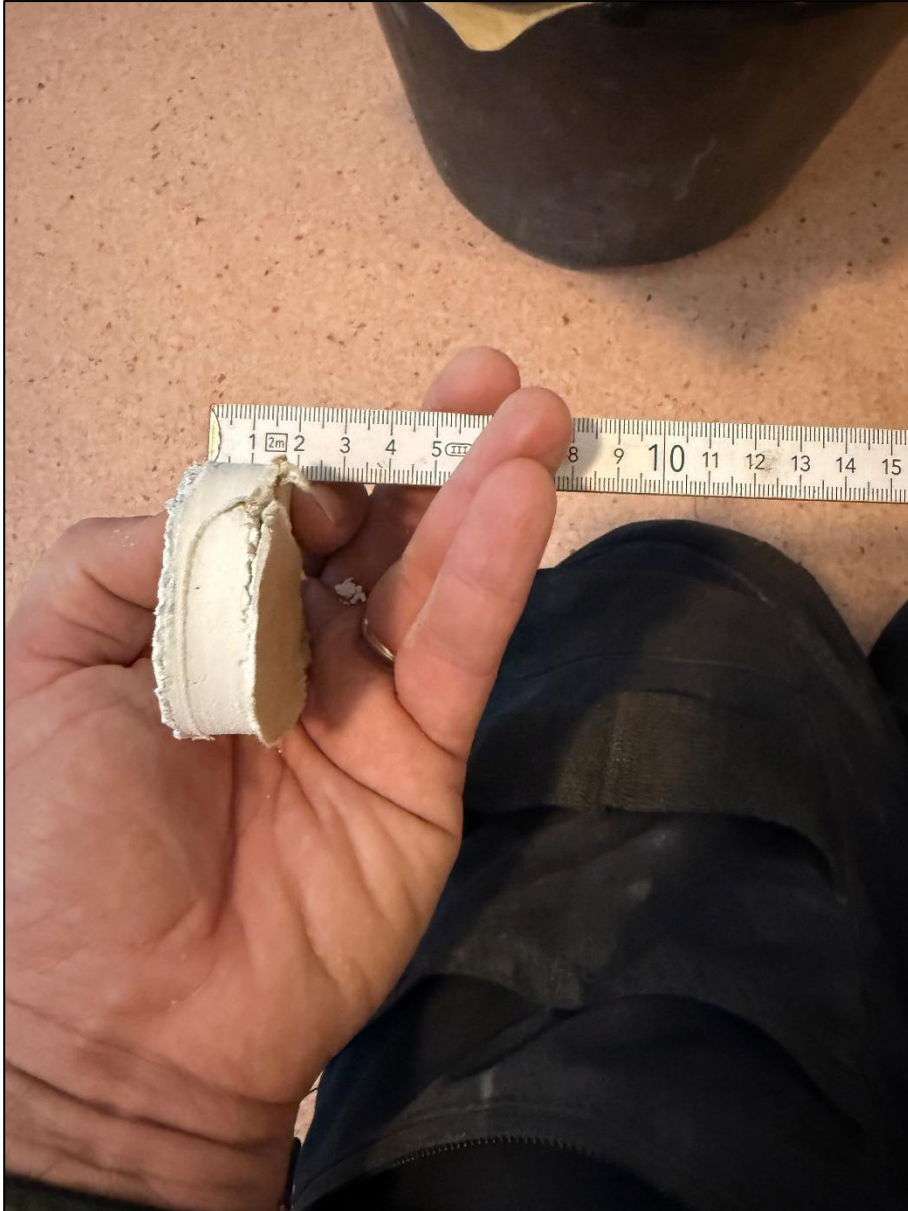
Bild 7: Schachtverkleidung Hausflur Gipskarton
