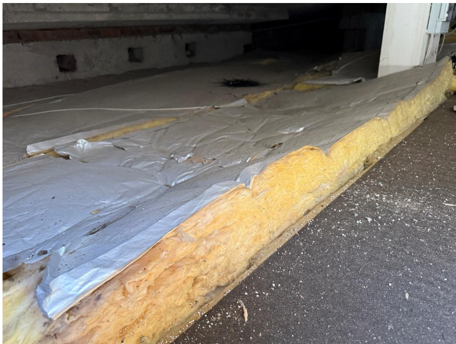
Bild 4: Dachdrempe mit Dämmauflage Glaswolle „Isover“
