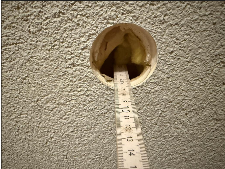
Bild 5: Trockenbauwand Hausflur mit Gipskarton und Mineralwolledämmung „Isover“
