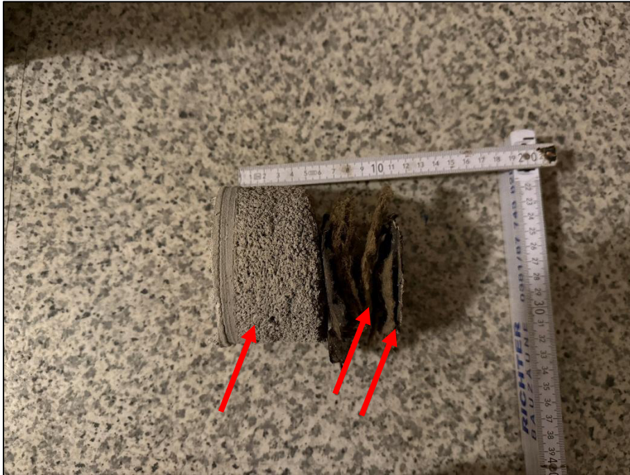
Bild 1: Fußbodenaufbau Hausflure mit Betonestrich, teerhaltiger Sperrpappe und Mineralwolle „Kamilit“
